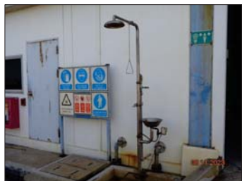
รูปที่ 17 อ่างล้างตา และฝักบัวล้างตัวในพื้นที่โครงการ
