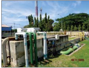
รูปที่ 7 บ่อพักน้ำทิ้งสุดท้าย (Final check basin)
